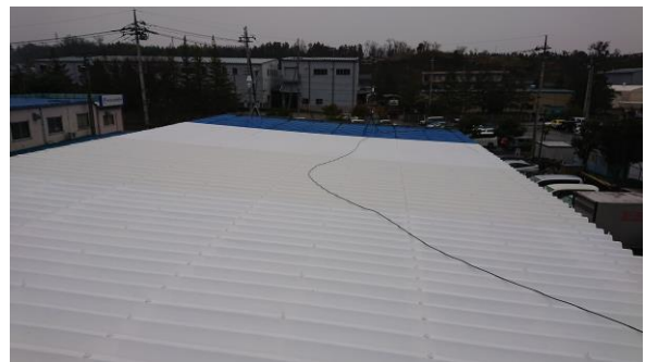
図3 塗装後の屋根状況
