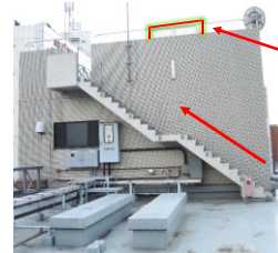
高架水槽への階段(安全な昇降)
