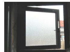
PSの外壁開口部
