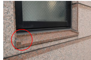
両端の入隅の処理
