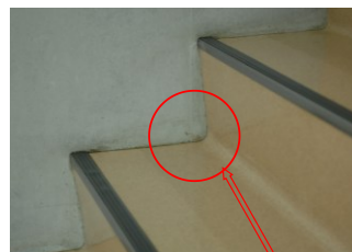
蹴上と踏面の取り合いをアール施工(粉塵等汚れ防止)
