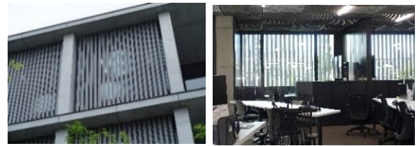
(1) 木虫籠ルーバー外観 (2) 木虫籠ルーバー内観
