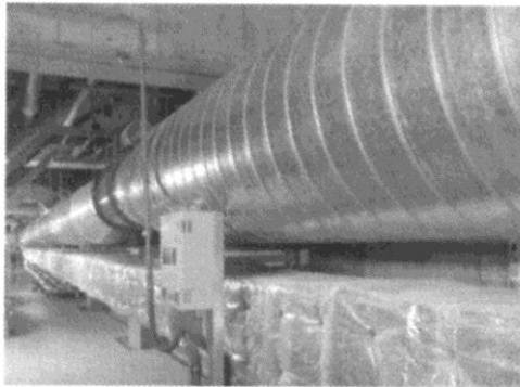
写真 1 トレンチ内に敷設した無断熱金属製ダクト 23号館 地中熱・間接利用
