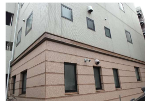
写真3-2 Aビルの外装
