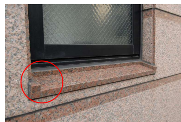
写真3-5 両端の入隅の処理
