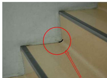
写真3-20 蹴上と踏面の取り合いをアール施工 (粉塵等汚れ防止)
