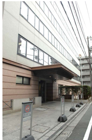
写真3-1 Aビルの外観
