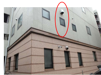
写真3-24 PSの外壁開口部 (外観)
