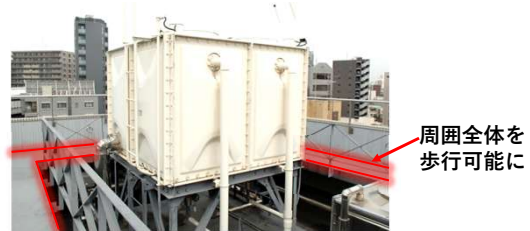
写真3-36 高架水槽周りの作業床
