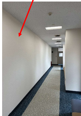
写真3-17 軽量鉄骨下地石膏ボード貼り内部壁
