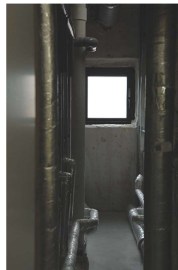
写真3-23 PSの外壁開口部 (PS内部)
