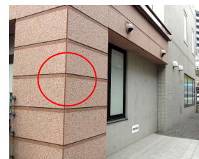
写真3-3 Aビルの外装仕上げ
