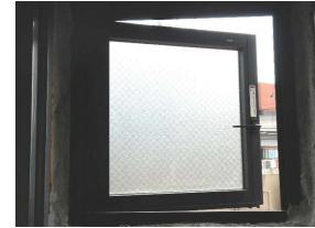
写真3-26 P Sの外壁開口部
