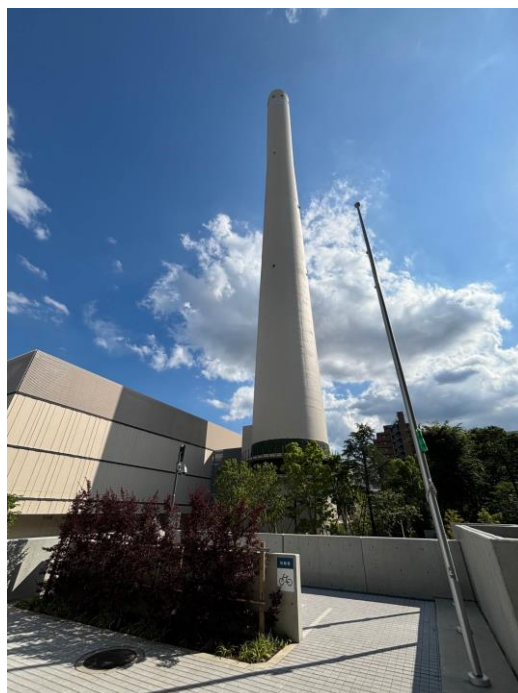
写真 玄関から見た煙突
